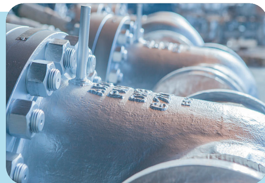
Montage et démontage de brides et d'assemblages filetés, de soupapes de vannes surchauffantes.
